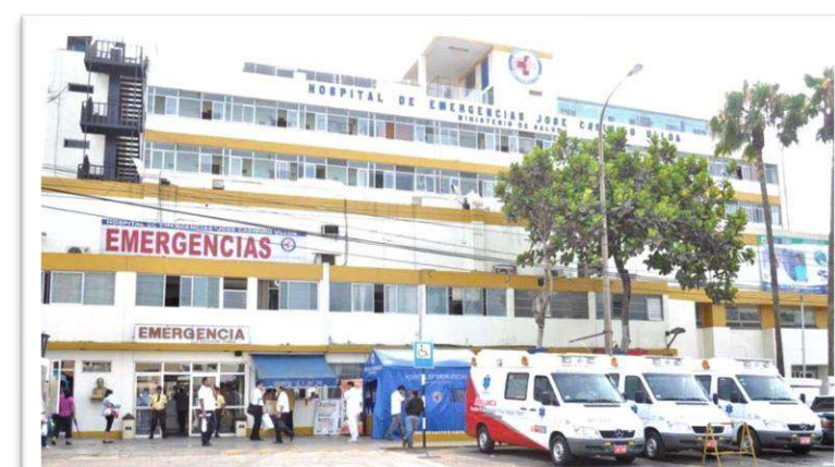
HOSPITAL DE EMERGENCIAS JOSÉ CASIMIRO ULLOA
