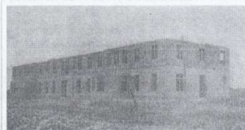
Figura 2. Construcción del Pab. 10-11
