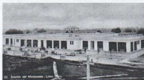
Figura 3. Vista anterior del Pabellón N° 02
