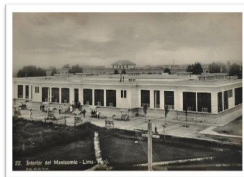
Figura 8. Vista anterior del Pabellón N° 02
