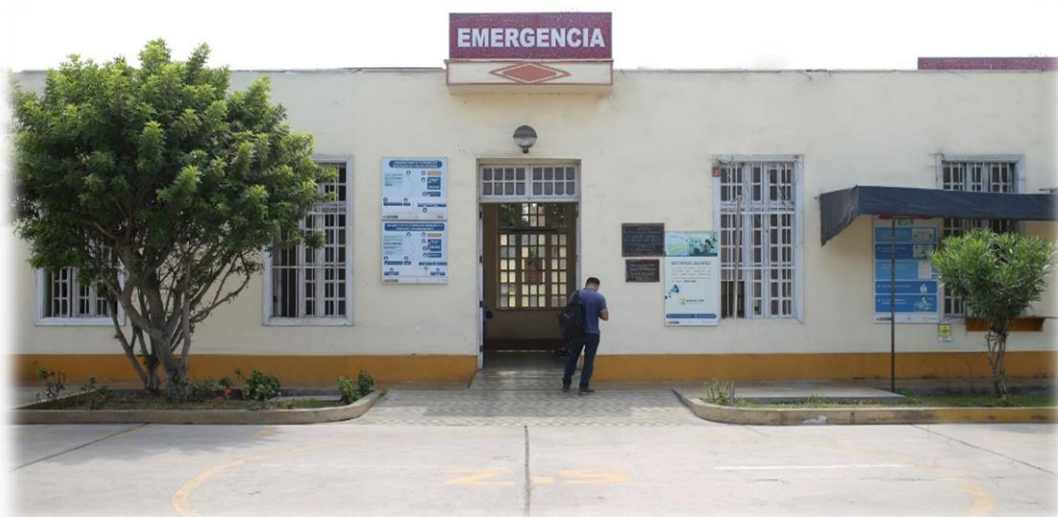
Figura 18. Pabellón 3 (Departamento de Emergencia)
