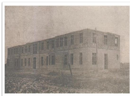
Figura 6. Construcción del Pab. 10-11
