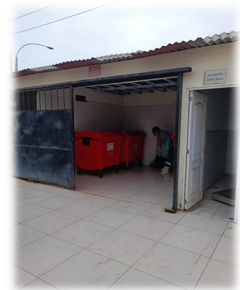
Supervisión de limpieza de centro de acopio de residuos sólidos
