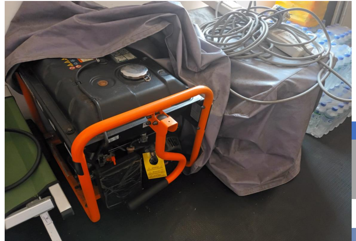
Mantenimiento de generadores de Corriente eléctrica
