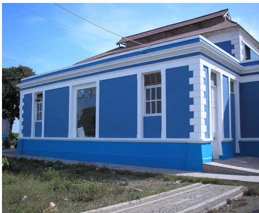
Pintado y acondicionamiento de exteriores
