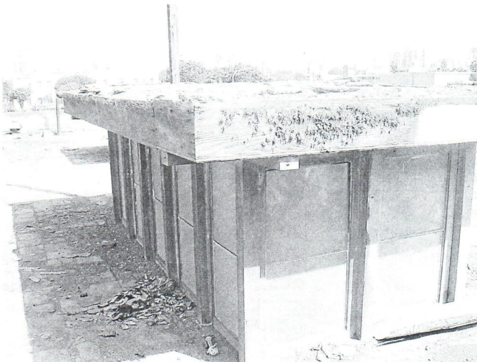
Pabellon N° 09 Tragaluz con estructura deteriorada
